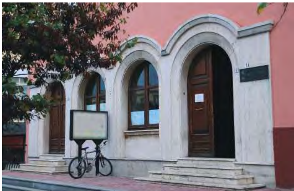
Esterno della biblioteca Outside of the library
